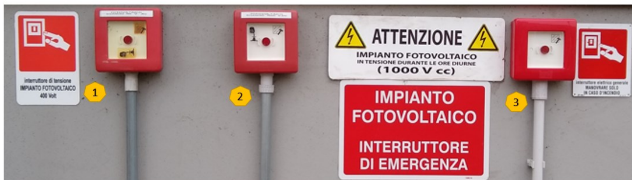
FOTOVOLTAICO SGANCIO 400 V.AC
