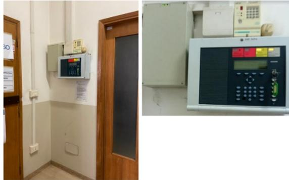
La centrale di rivelazione incendi è ubicata nel locale PTB.E32.PTE.T41 (piano terra, corridoio, sulla sinistra entrando da C.so Porta Mare, 2). Il sistema di rivelazione incendi si allarma tramite pulsanti manuali antincendio e sensori ottici di fumo automatici.
