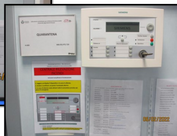
RIPETITORE ALLARME INCENDIO
